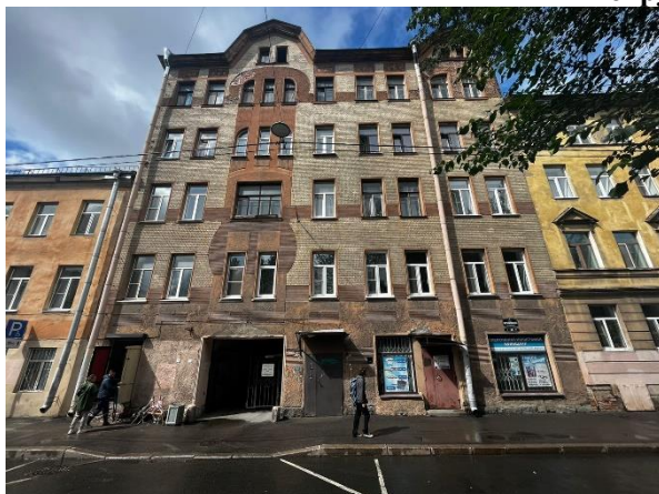
Фото 1. Вид здания, в котором расположен Объект оценки
