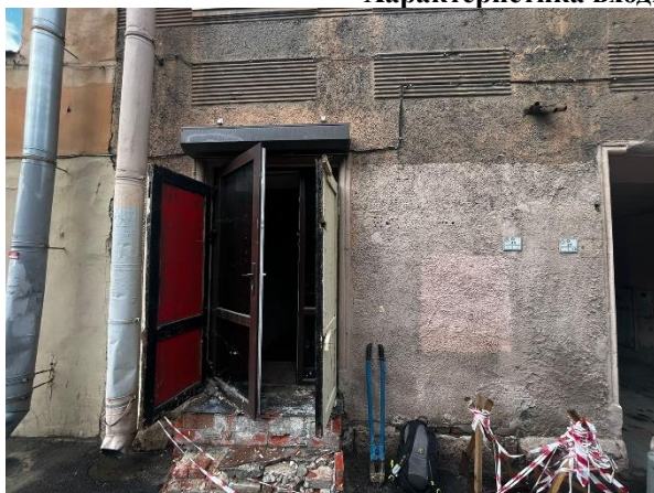
Фото 3. 1 отдельный вход с улицы
